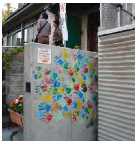
外付けリフトが完成した「さわやか港南」の外観(写真上) 段差のある建物ですが、外付けリフトができたので誰もが立ち寄れる「居場所」ができました。 増設された明るい相談ルーム(写真中) みんなで壁塗りもしてつくりあげました。さりげなくお茶を飲みながら話すことで解決できることも多いのです。 約束手形(写真下) まちのふれあい活動に参加しますという約束手形。
