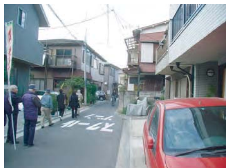
セットバックしたところから、へび玉状であっても舗装が行われた道路
