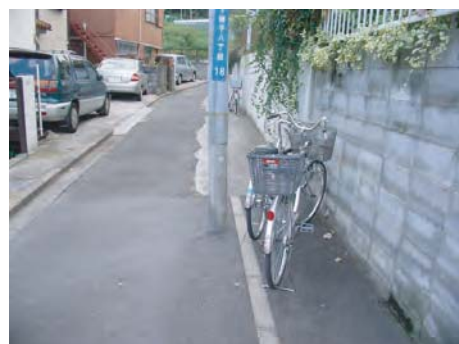
道路が拡幅されても移設されない電柱
