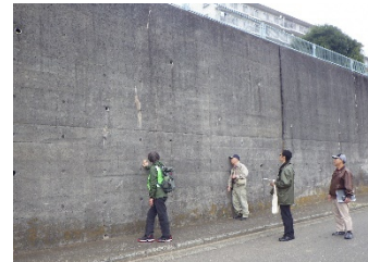
水取沢防災まちづくりの会による擁壁点検
