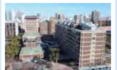
※ 現市庁舎建物は、開港百周年事業の一環として指名設計競技が行われ、村野藤吾氏の設計案が採用されました。昭和34年に竣工しています。
