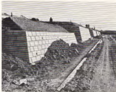
造成中の団地 昭和48年2月3日撮影
