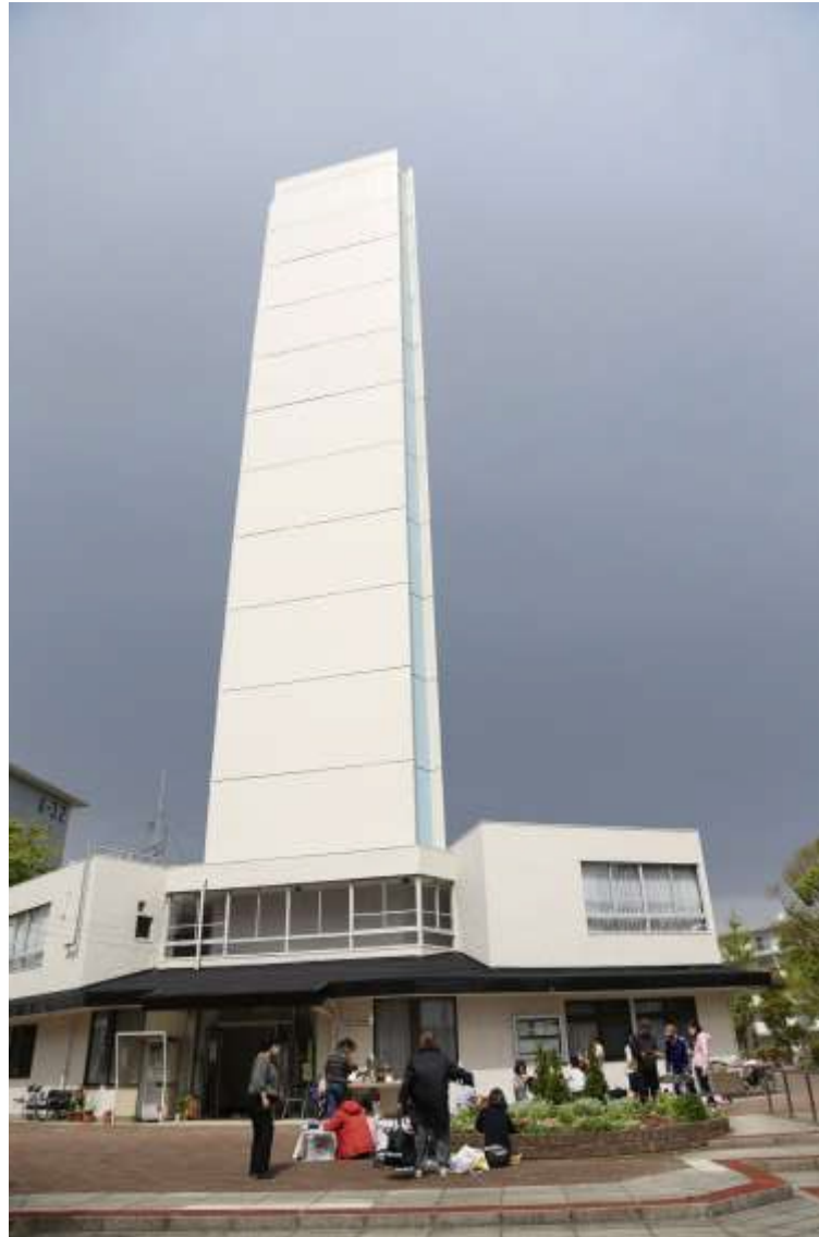
給水塔 旧管理事務所棟 高さ 41.9m 重量 2,102トン
