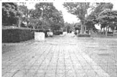
※団地内に整備された緑道
