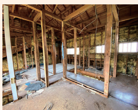
既存壁等解体
