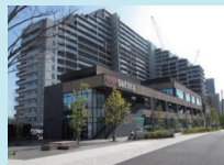
よこはま多世代・地域交流型住宅 (港北区箕輪町)
