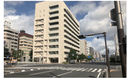
沿道建築物の耐震化
