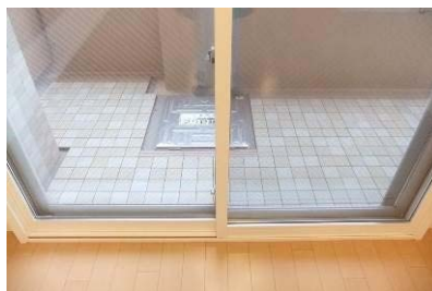
エコリノベーション 補助対象工事例（内窓設置）
