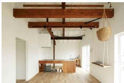
エコリノベーション 補助対象工事例
