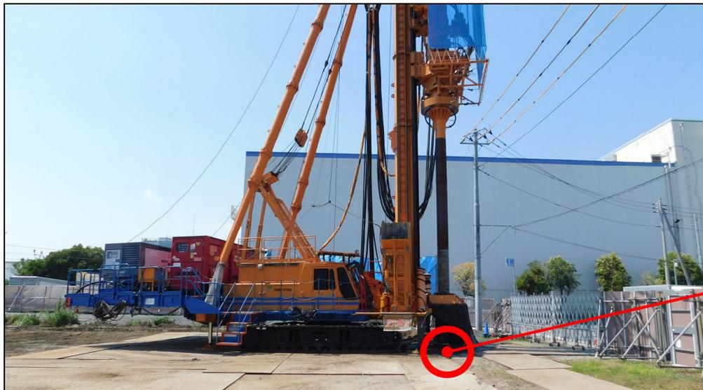
地盤改良(静的締固め砂杭工法)
