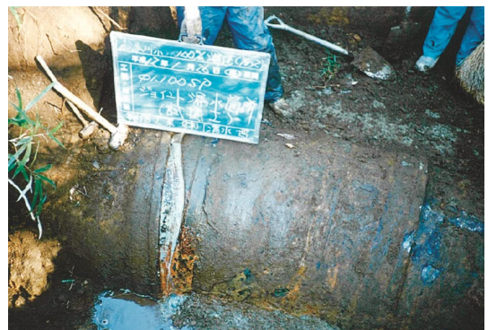
鉛継手の漏水修理
