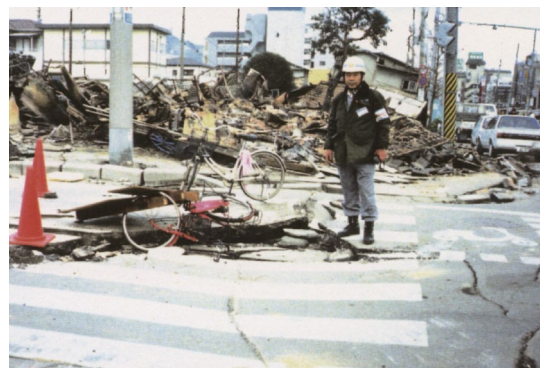
水道管破裂現場
