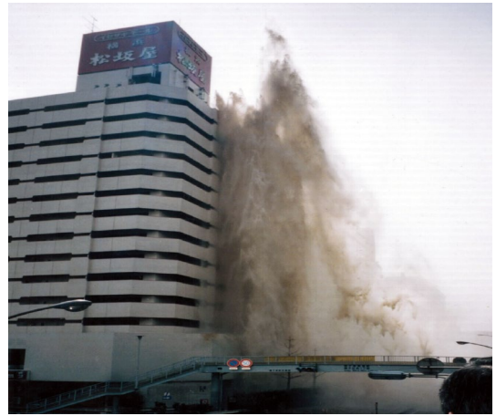
磯子幹線破裂事故現場
