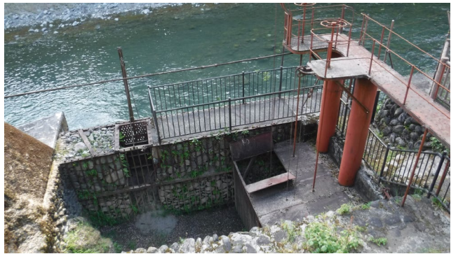
復元・整備された旧青山取水施設
