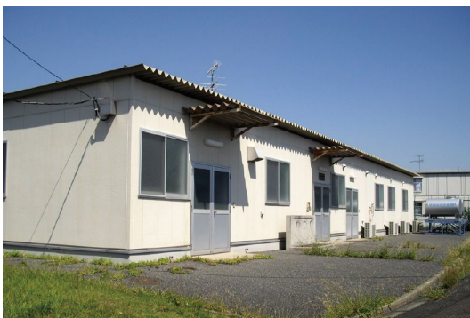
応援者受け入れ拠点(磯子配水池)
