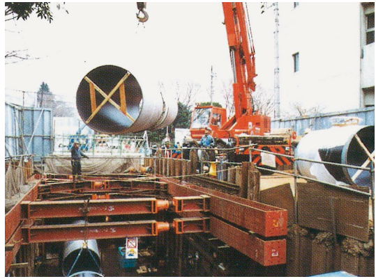
導水管の布設替え
