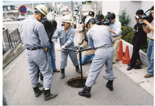
取水制限に伴う減圧給水作業 1996（平成8）年7月
