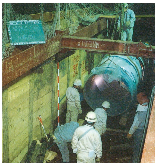
送水管布設工事
