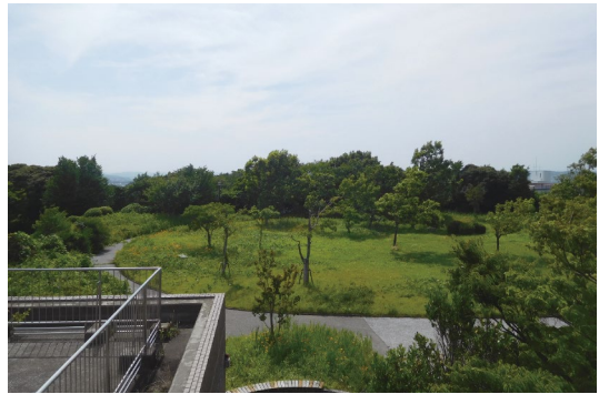
港南台2号配水池（港南台さえずりの丘公園）
