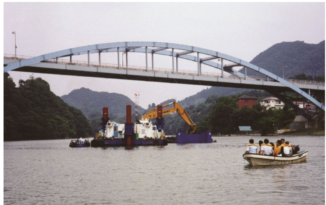
相模湖堆積土砂の浚渫船 1999（平成11）年
