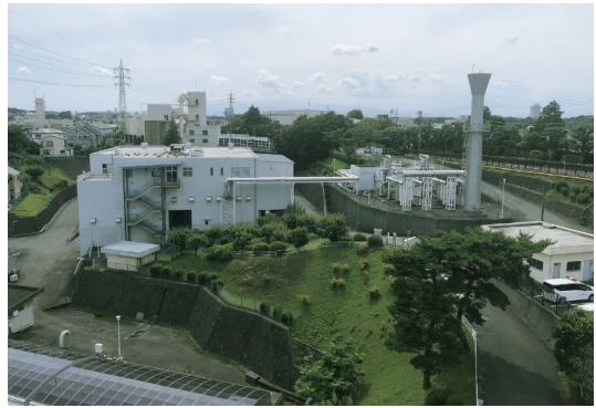
西谷排水処理施設
