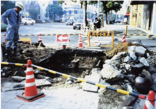
被災地での漏水修理
