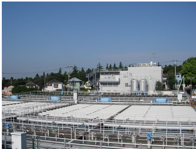
<工業用水道鶴ヶ峰沈でん池>
