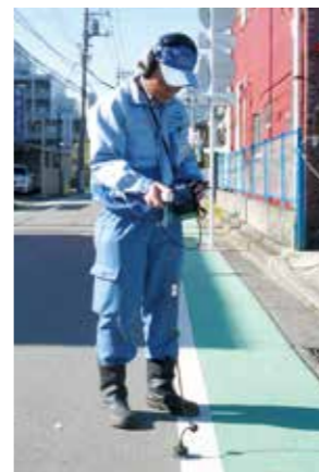
道路での漏水調査
