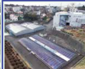
排水処理施設
