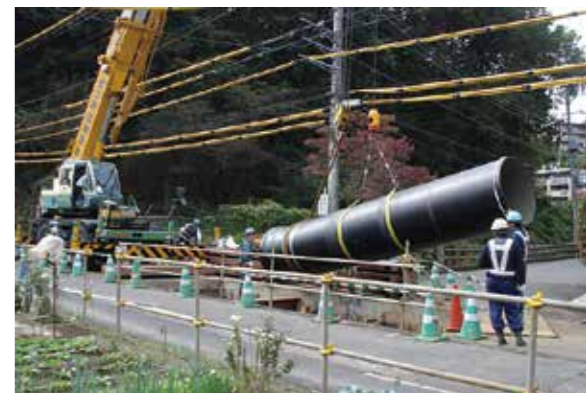
地震に強い水道管への取り替え工事
