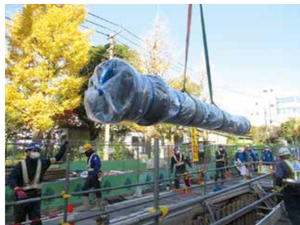
送配水管の更新工事
