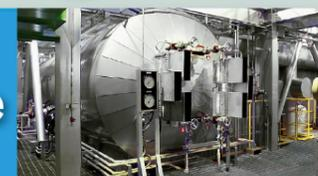
La chaudière est un système qui produit de la vapeur en utilisant la chaleur produite par la combustion des ordures ménagères. La vapeur ainsi produite est envoyée vers le « turboalternateur », où elle est utilisée pour produire de l'électricité. La vapeur est également utilisée comme source de chaleur pour les systèmes de chauffage-climatisation et de production d'eau chaude de l'usine d'incinération, ainsi que pour les équipements voisins (piscine chauffée et bains).
