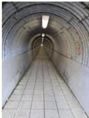
大原隧道内部
