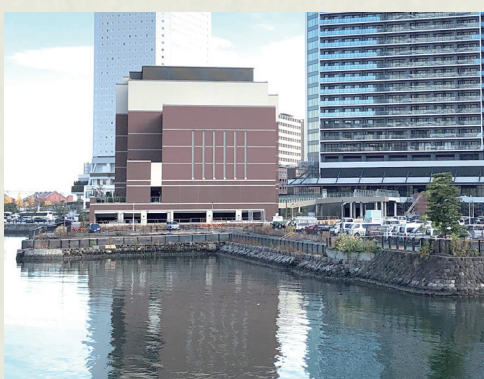
「旧灯台寮護岸」 2019(令和元)年撮影
