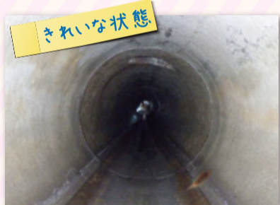
▲下水管(管径約 25センチ)の内部の ようす
