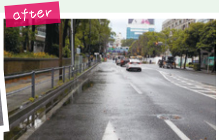
▲パトロールで発見した際には、街きょ樹(雨水を下水道本管に送る施設)の詰まりを解消し、通行の安全を確保します
