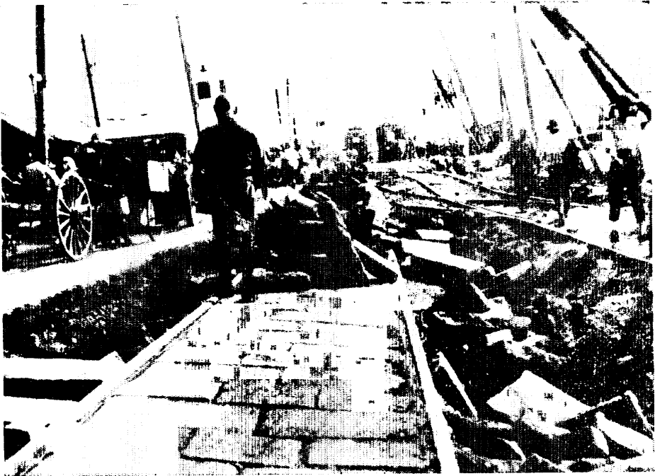
震災の惨状——長者町方面、市電の軌道を復旧する〈加藤直方氏提供〉
