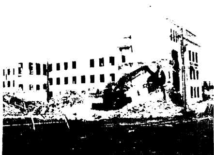
返還後解体されるアメリカの中学校（旧、本牧小学校校舎）
