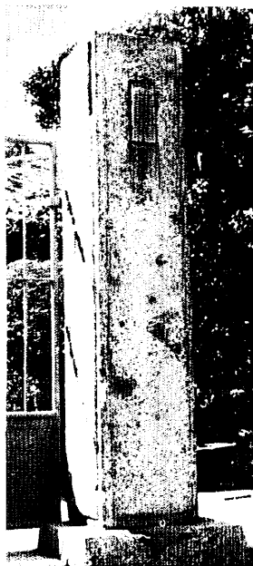
破片でえぐられた門柱―黒い部分がその痕、ただし最近では風化がすすんでいる(山口菊美氏提供)
