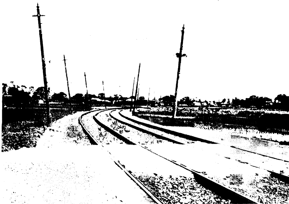
―三ヶ田停留所付近
