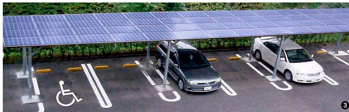
高速側駐車場に設置
