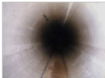
更生工法施工後
