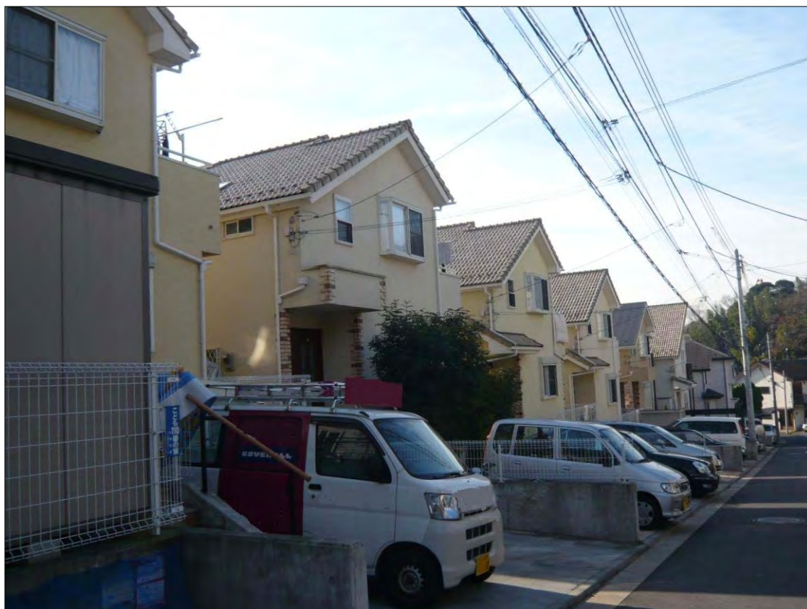
○写真④ D地区(北側から)
