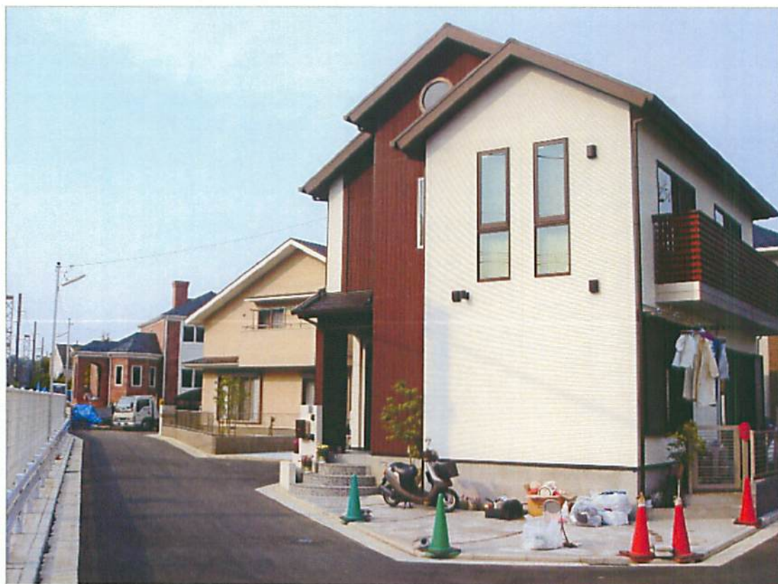
写真⑤ B住宅ゾーン【B-1 地区】
