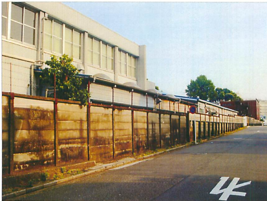
写真⑨ C地区 工場
