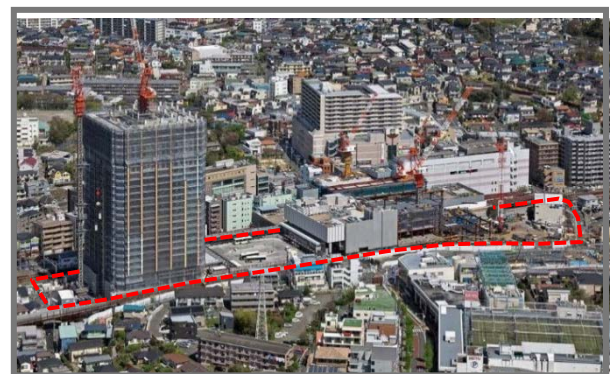
二俣川駅南口地区市街地再開発事業（事業中）
