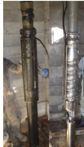
【写真】老朽化したポンプ(左)と更新したポンプ(右)(緑区)
