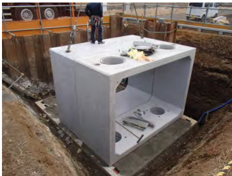
【写真】地下貯水槽の設置(緑区)
