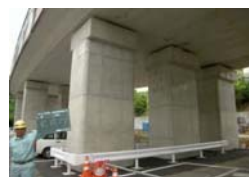
橋梁の耐震化 (谷津坂第一高架橋)
