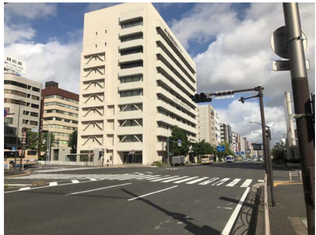
沿道建築物の耐震化の事例
