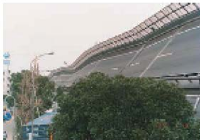
阪神高速道路の高架橋の倒壊
