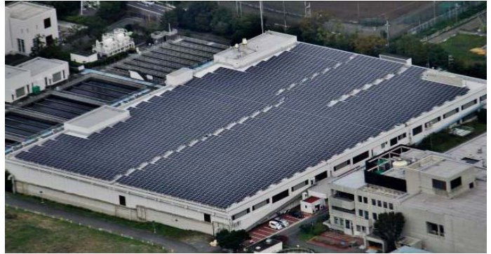
西部水再生センターのメガソーラー (災害時は応急対策に必要な電源を供給)
