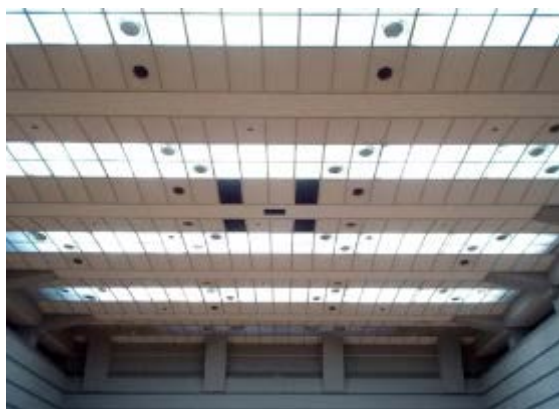
磯子スポーツセンター天井脱落対策（左：改修前 右：改修後）
