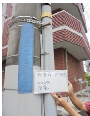
街区表示板作業前
