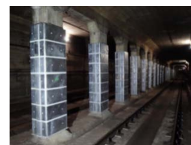
<開削トンネル RC 中柱耐震補強>
