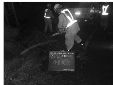
チェーンソーによる倒木の切除
