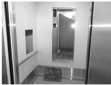
更新後(かご内部)
