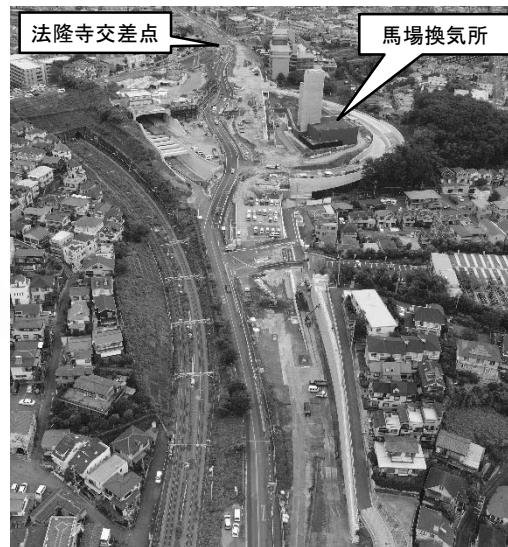
工事実施状況(平成30年9月)
