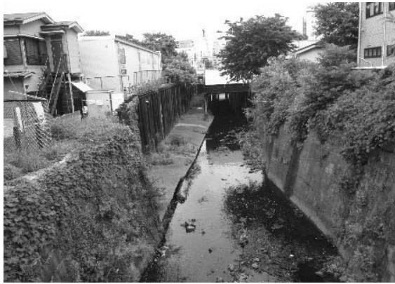
護岸改修 (今井川：保土ヶ谷区岩井町)
