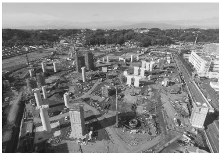
①栄IC・JCT下部工事 (栄区田谷町) 平成30年12月
