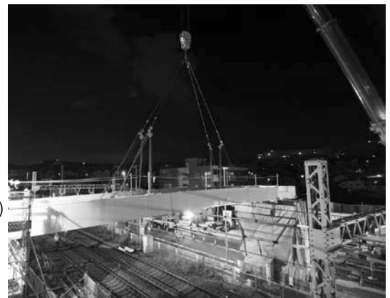
架替え:かたぶき人道橋(金沢区)
