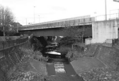
護岸改修 (和泉川：泉区和泉町)
