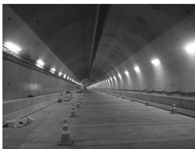
シールドトンネル坑内 （平成30年11月）
