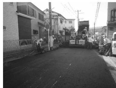
舗装修繕工事の状況(泉区)
