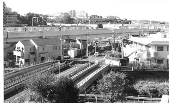
全線高架化後(星川2号踏切)
