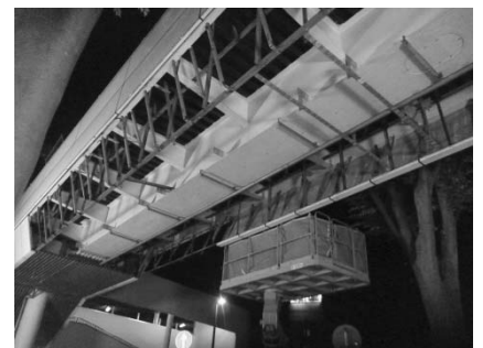
化粧パネルの撤去：戸塚駅東口歩道橋(戸塚区)
