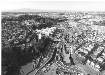
②公田地区掘削試験工事 (栄区公田町) 平成30年12月
