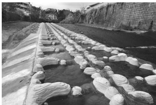
整備した魚道 (帷子川: 旭区今川町)
