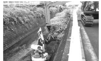
堆積土砂の掘削状況(帷子川)
