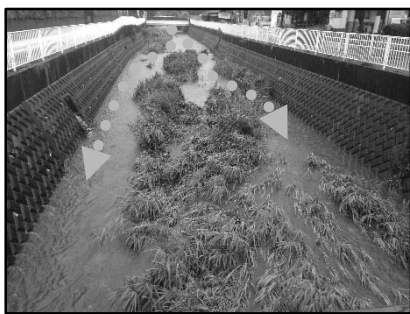
<土砂堆積の影響による洗堀>
