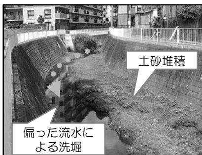
<土砂堆積の影響による洗堀>
