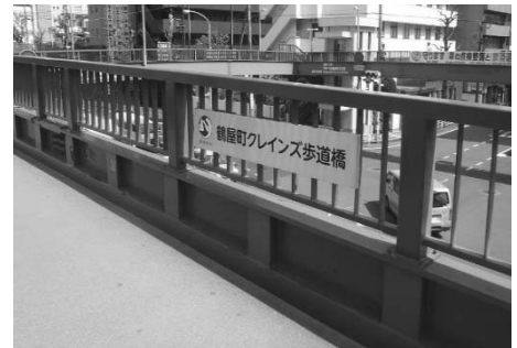
鶴屋町クレインズ歩道橋
