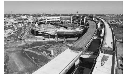
整備中の横浜環状北西線(横浜港北JCT)
