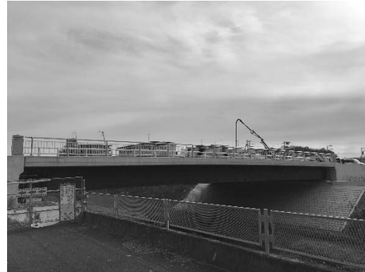
早淵川に架かる橋梁架設後の状況
