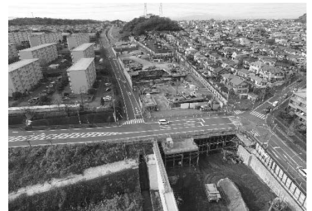
③上郷桂台地区立坑築造工事 (栄区上郷町) 平成30年12月
