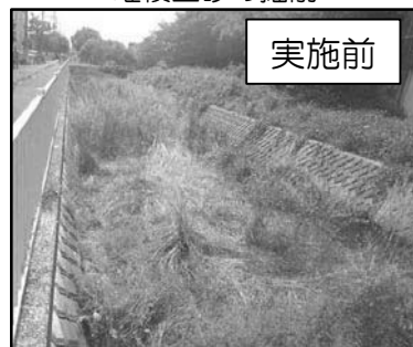
堆積土砂の掘削
