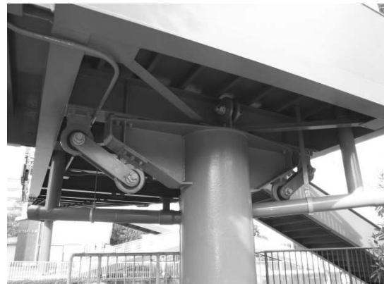
落橋防止装置:鶴見神社前歩道橋(鶴見区)
