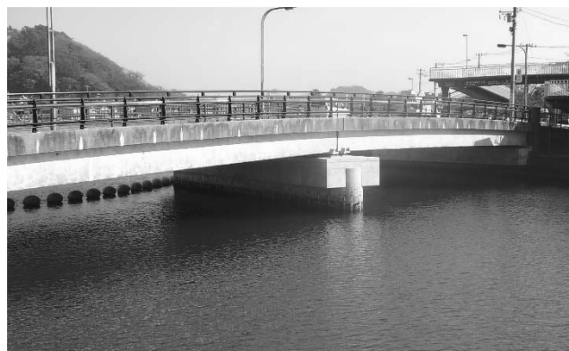
耐震補強を行った平潟橋（金沢区）
