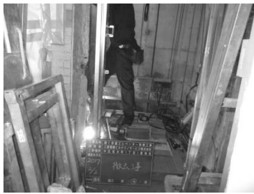
エレベーター撤去工事
