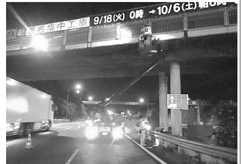
近接目視点検：東名高速道路上の橋梁
