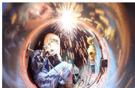
老朽管耐震更新工事（管内溶接）
