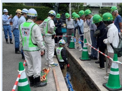
工事現場見学会
