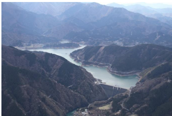
宮ヶ瀬ダム (平成 13 年完成)
