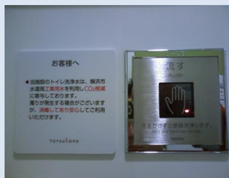
商業施設のトイレ用水
