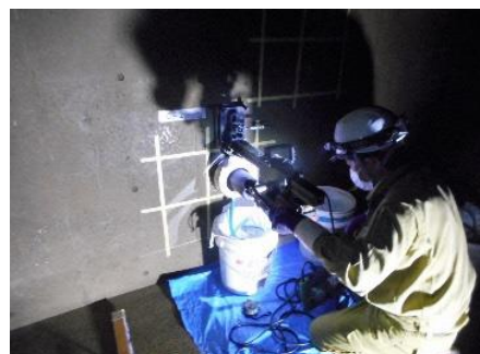
配水池の健全度調査の作業状況
