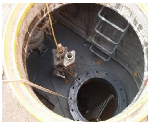
災害用地下給水タンクの点検
