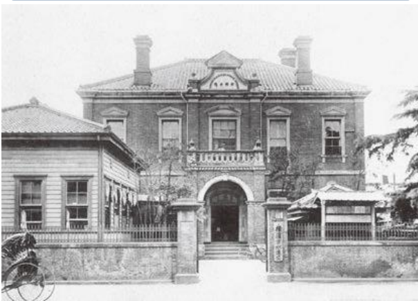
創設当時の横浜水道事務所
