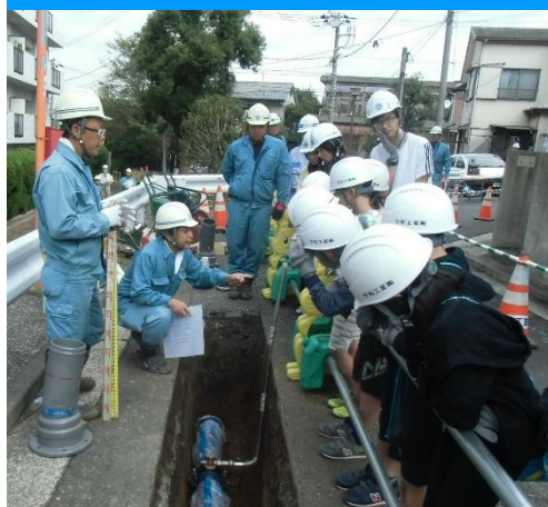
工事現場見学会
