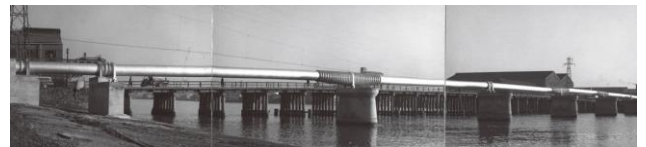
京浜工業地帯へ工業用水を供給する水管橋
