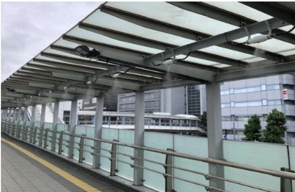
ミスト装置の設置風景（新横浜駅前）
