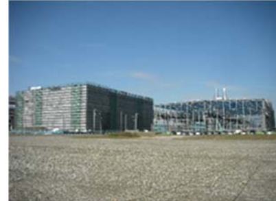
A突堤で建設が進むロジスティクス施設
