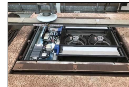
&lt;強制換気装置（天井部）&gt;
