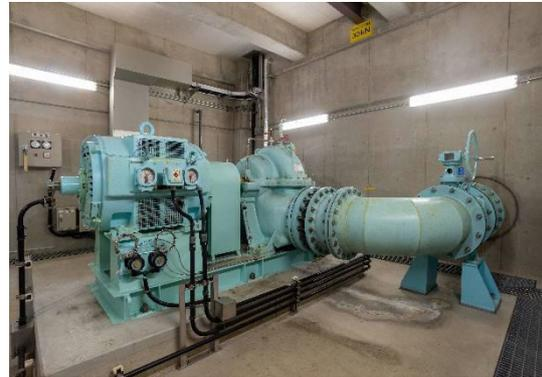
写真4 小水力発電設備（水運用センター）
