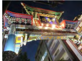
牌樓の修繕 【中華街発展会協同組合】
