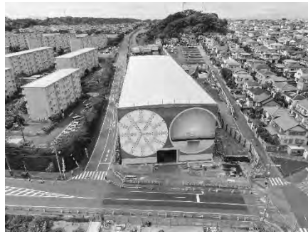
桂台トンネル工事(栄区上郷町)
