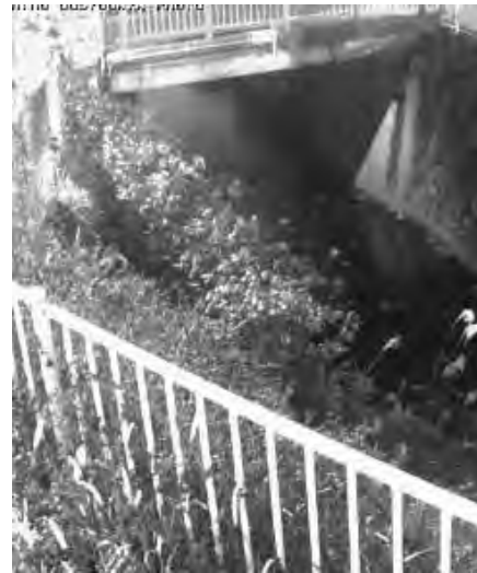
令和2年度に新設した監視カメラの画像 (港南区 御所が谷橋 (準用河川日野川))
