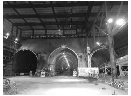
庄戸トンネル工事(栄区庄戸)
