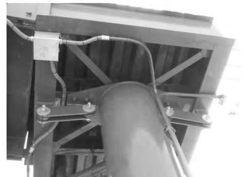
狩場第三歩道橋(保土ヶ谷区): 落橋防止装置 平成31年3月完成
