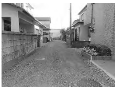
私道整備助成実施前(泉区)
