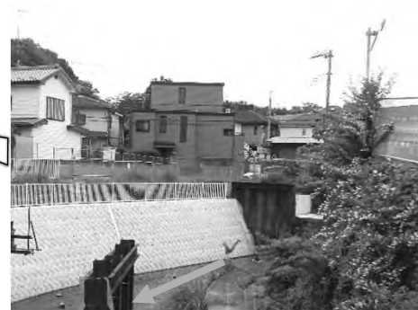
施工状況 御所が谷橋下流部：港南区日野七丁目
