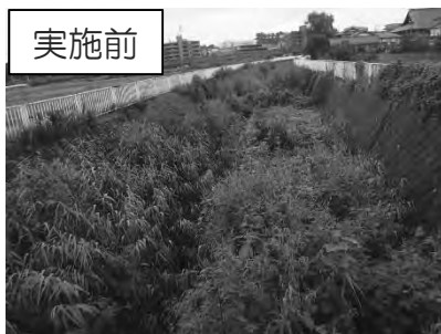
土砂掘削等による河道断面確保 (一級河川梅田川)
