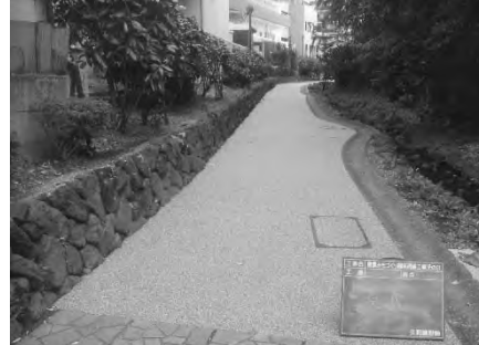
透水性舗装への改修
