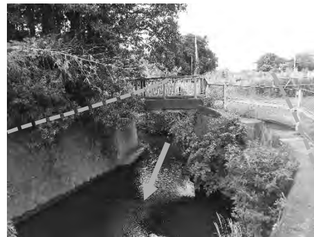
橋際橋架替え 阿久和川：泉区新橋町
