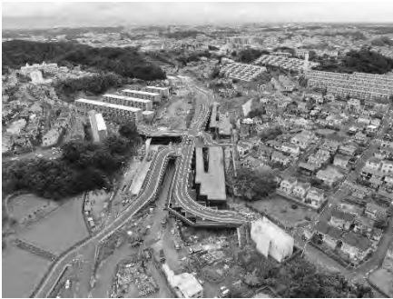
公田IC築造工事(栄区公田町)
