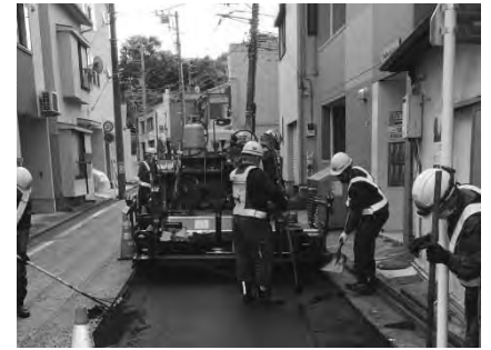
舗装修繕工事の状況(西区)
