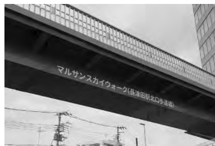
主桁への愛称標示
