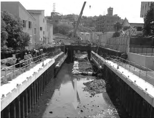
護岸改修 (今井川：保土ヶ谷区岩井町)
