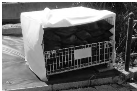
土のうステーション 設置例 (磯子区)
