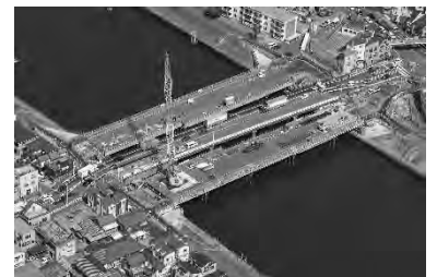
橋梁の架け替え(末吉橋)
