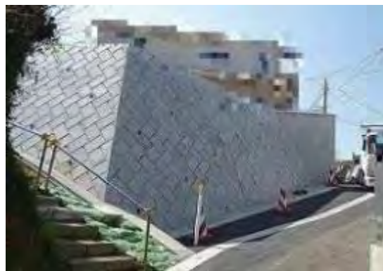
改善後（間知ブロック石積擁壁）
