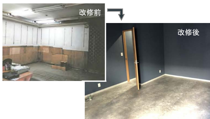
空き店舗の壁・床・天井等の内装を改修(令和3年度)
