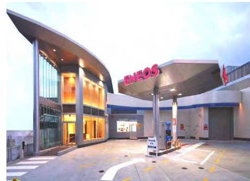
ENEOS 横浜綱島水素ステーション
