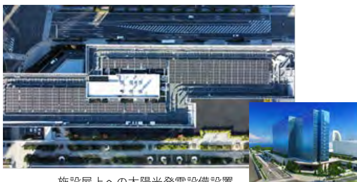
施設屋上への太陽光発電設備設置
