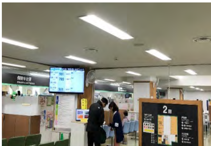
区役所の照明LED化
