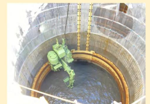
写真6 立坑築造工
