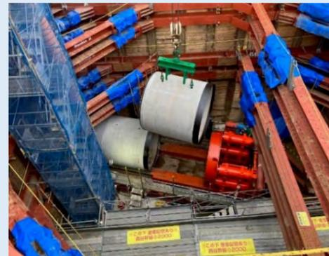
写真2 場内管路切り回し工
