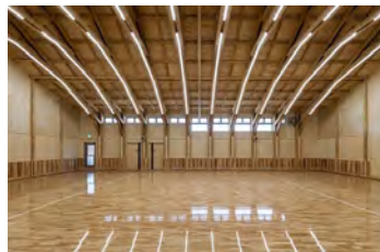
新井中学校（保土ヶ谷区） 木造武道場〔令和4年度整備〕
