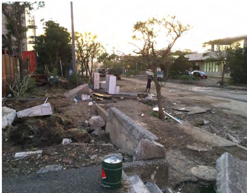
令和元年台風第15号の際の被害の様子
