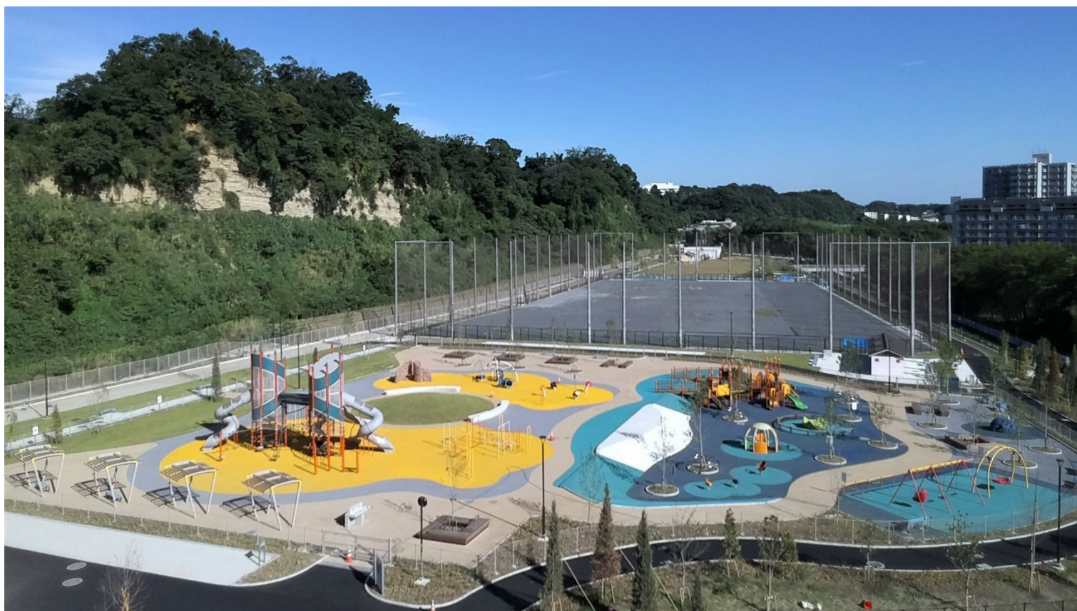
インクルーシブ遊具広場と多目的広場(整備中)
