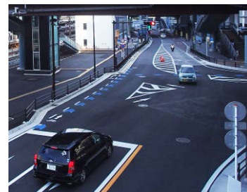
矢羽根型の路面表示の設置
