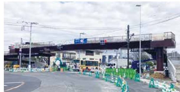
▲完成間近の歩道橋(3月7日時点)
