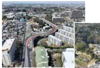
▲国道1号につながった環状3号線
