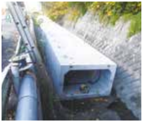
▲水路の地下化工事
