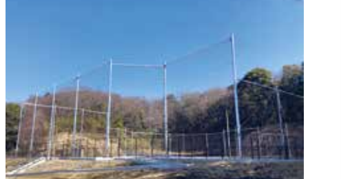
▲3月に完成した打越広場
