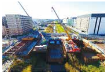
▲早期完成を目指し工事が進められている高島橋架け替え工事
