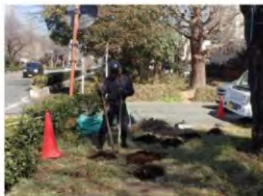
土壌改良作業のイメージ ダブルスコップによる掘削
