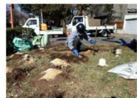
埋め戻し作業
